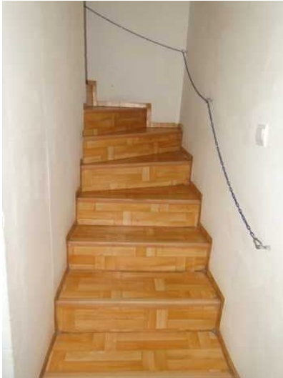
Schodiště do podkroví
